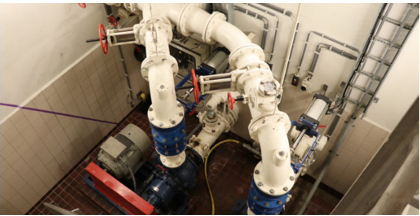
Het afvalwater wordt door de gemeente ingezameld met riolering en stroomt onder vrij-verval naar het hoofdrioolgemaal. Vanaf hier wordt het door het waterschap onder hoge druk in een persleiding getransporteerd naar de zuiveringsinstallatie.
