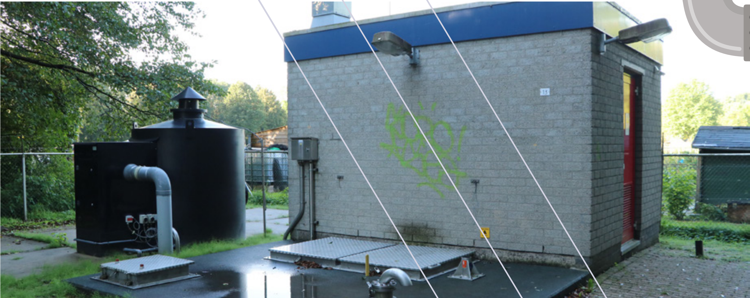
Het afvalwater wordt door de gemeente ingezameld met riolering en stroomt onder vrij-verval naar het hoofdrioolgemaal. Vanaf hier wordt het door het waterschap onder hoge druk in een persleiding getransporteerd naar de zuiveringsinstallatie.
