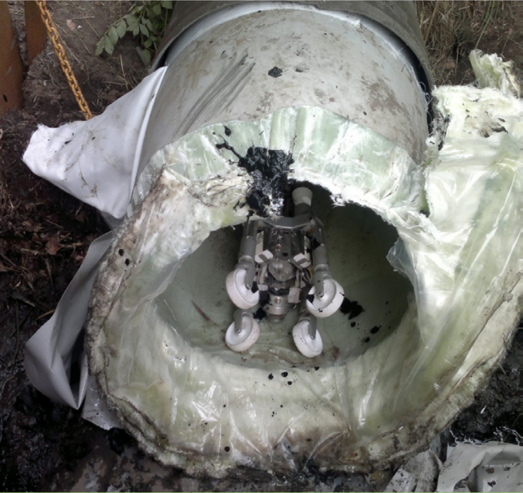
Relinen is een renovatiemethode om de kwaliteit van een rioolstreng te herstellen zonder deze te vervangen. Het is goedkoper dan rioolvervanging, maar niet in elke situatie toepasbaar.
